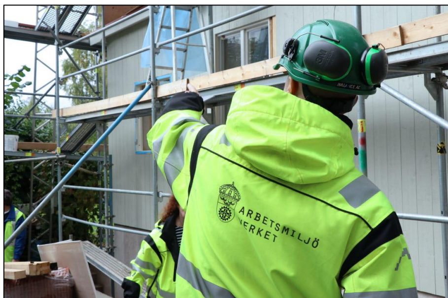
Bild 3. Myndighetsgemensam kontroll av en byggarbetsplats.
