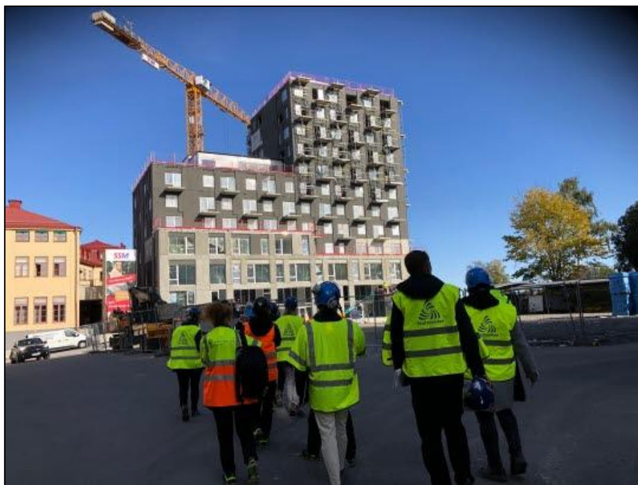
Bild 1. Myndighetsgemensam kontroll av en byggarbetsplats.
